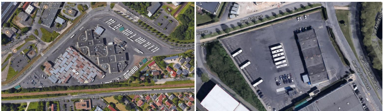
Centres de maintenance de Saint-Jean-de-Braye et de la Source à Orléans (source : maps.google.fr)
